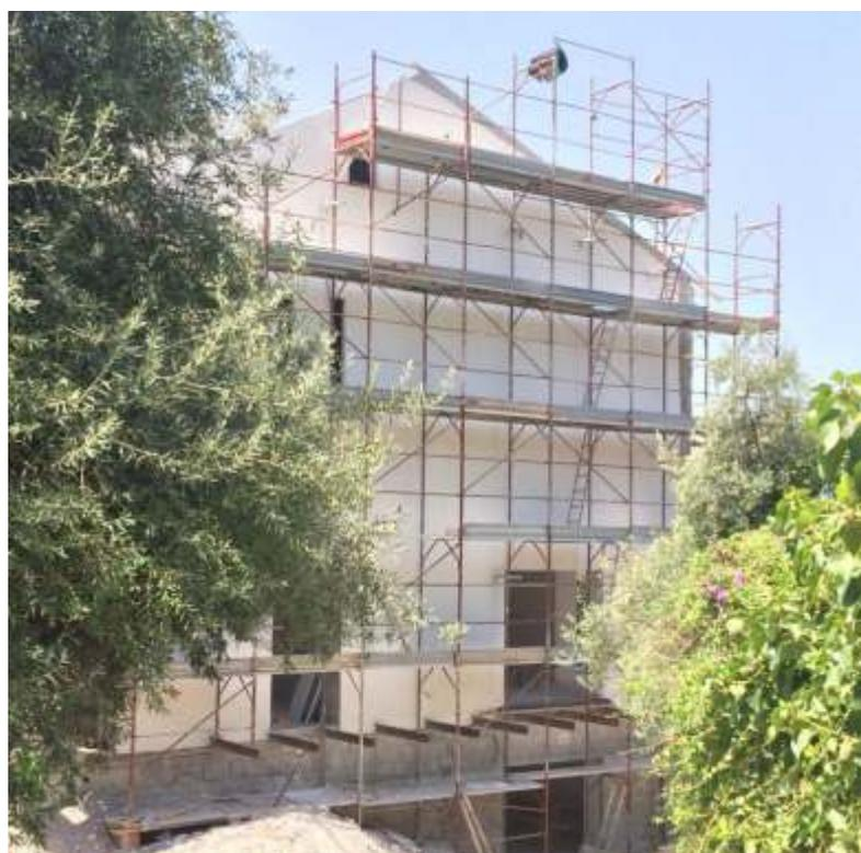
**L'ISOLAMENTO TERMICO CON INTONACO TERMOISOLANTE CONSENTE LA REALIZZAZIONE DI SUPERFICIE ISOLANTI CONTINUE, SENZA FUGHE, CHE SI ADEGUANO A TUTTE LE FORME GEOMETRICHE DEL SUPPORTO. L'ADERENZA E LA PERMEABILITÀ ELEVATA GARANTISCONO PARETI CALDE E ASCIUTTE E UN RISPARMIO ENERGETICO.**
